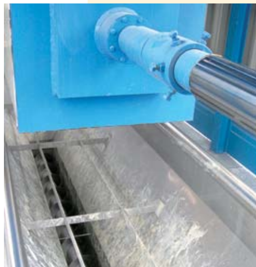
经排泥导板及螺旋输送机外送方式
