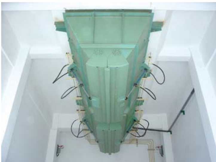
在压滤机下方装设泥斗，由卡车装载供进一步处理
