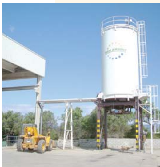
经泥饼输送泵外送到泥斗暂存，等待卡车载运
